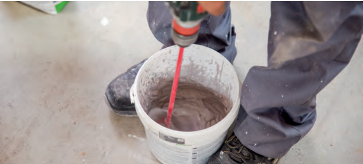
Prepare the grout | Prepara el material de rejuntado | Préparer le matériel de joint | Rühren Sie das Fugenmaterial an
