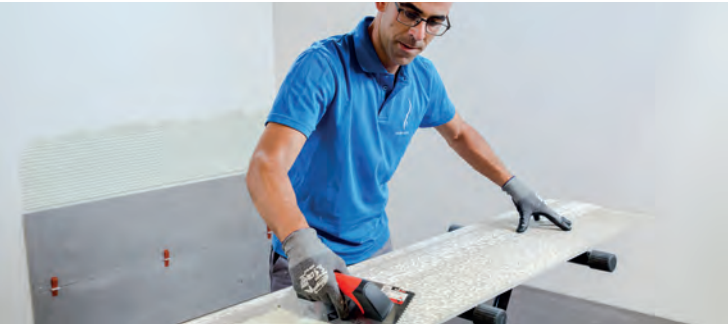
Spread the adhesive cement with a toothed trowel on the tile | Extiende el cemento de agarre con una llanta dentada sobre la pieza | Étendre le ciment à prise rapide à l'aide d'une spatule dentée sur la pièce | Verstreichen Sie den Klebemörtel mit einem Zahnspachtel auf der Fliese
