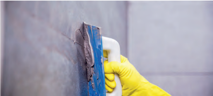
Use a grout trowel to affix the material | Utiliza una llana de rejuntado para fijar el material | Utiliser une spatule pour joints pour fixer le joint | Verwenden Sie eine Fugenkelle zum Andrücken des Materials
