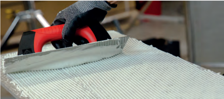
Make sure the thickness of the layer of adhesive cement is uniform | Asegúrate de que el grosor de la capa de cola sea uniforme | Veiller à ce que l'épaisseur de la couche de colle soit uniforme | Vergewissern Sie sich, dass die Kleberschicht gleichmäßig ist
