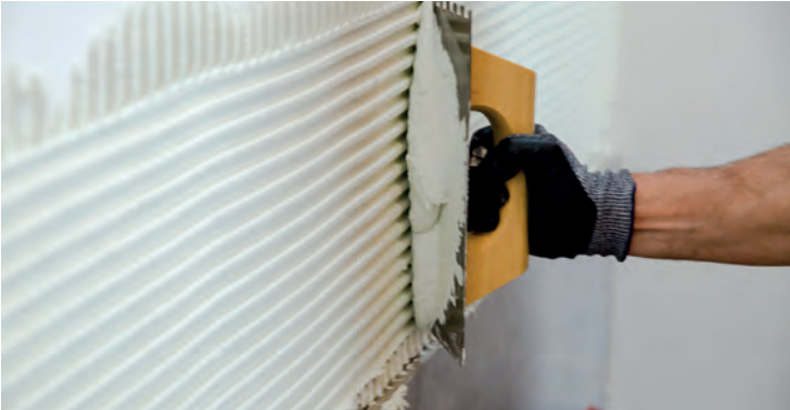
Make sure the thickness of the layer of adhesive cement is uniform | Asegúrate de que el grosor de la capa de cola sea uniforme | Veiller à ce que l'épaisseur de la couche de ciment colle soit uniforme | Vergewissern Sie sich, dass die Kleberschicht gleichmäßig ist
