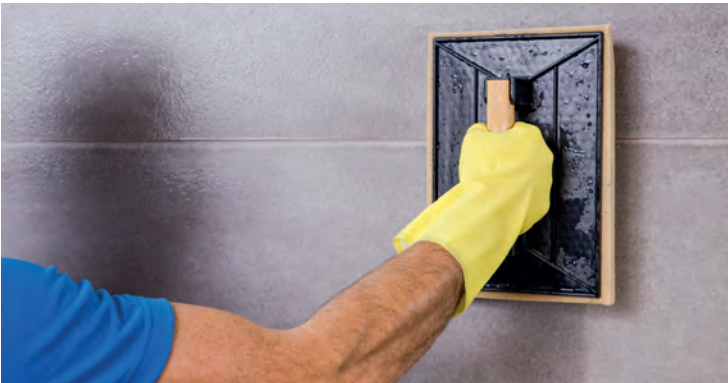
Remove any leftover grout and other dirt | Elimina los residuos de junta y demás suciedad | Éliminer les résidus du joints et autres saletés | Entfernen Sie Fugenmaterialreste und andere Verunreinigungen
