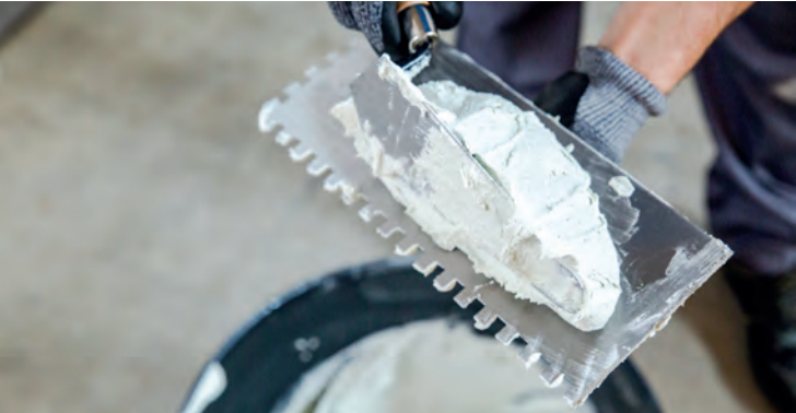
Spread the adhesive cement with a toothed trowel | Extiende el cemento de agarre con una llanta dentada | Étendre le ciment à prise rapide à l'aide d'une spatule dentée | Verstreichen Sie den Klebemörtel mit einem Zahnspachtel
