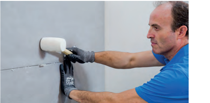
Use the flexible rubber mallet | Utiliza una maza de goma flexible | Utiliser un maillet en caoutchouc souple | Verwenden Sie einen biegsamen Gummihammer
