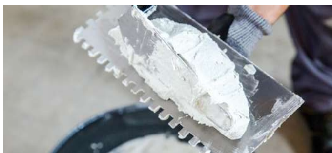
Spread the adhesive cement with a toothed trowel | Extiende el cemento de agarre con una llana dentada | Étendre le ciment à prise rapide à l'aide d'une spatule dentée | Verstreichen Sie den Klebemörtel mit einem Zahnpachtel
