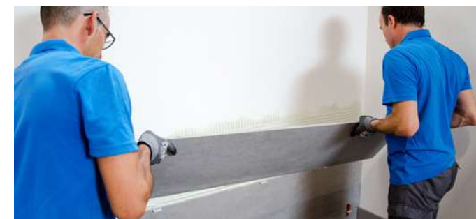
Affix the tile to the pre-prepared surface | Coloca la pieza sobre la superficie preparada | Placer la pièce sur la surface préparée | Verlegen Sie die Fliese auf der vorbereiteten Oberfläche
