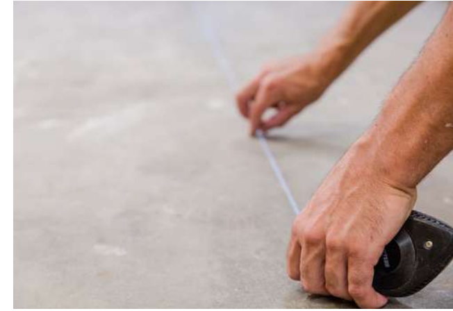
Set the guideline | Plantea la línea maestra | Établir la ligne magistrale | Spannen Sie die Richtschnur
