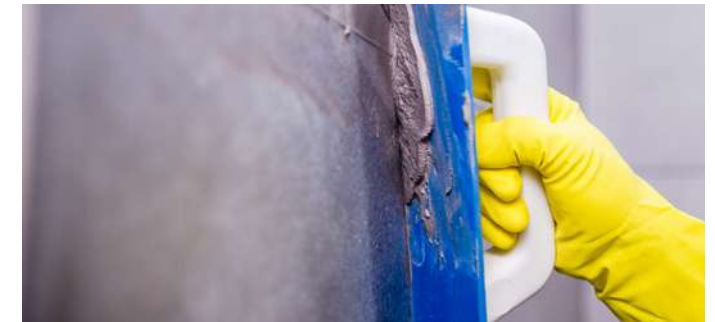
Use a grout trowel to affix the material | Utiliza una llana de rejuntado para fijar el material | Utiliser une spatule pour joints pour fixer le matériau | Verwenden Sie eine Fugenkelle zum Andrücken des Materials
