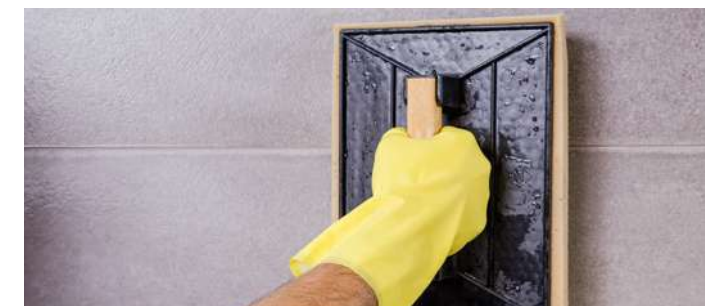
Remove any leftover grout and other dirt | Elimina los residuos de junta y demás suciedad | Éliminer les résidus de jointoiment et autres saletés | Entfernen Sie Fugenmaterialreste und andere Verunreinigungen
